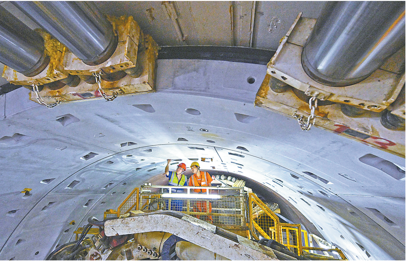
▲►10月2日，中铁十四局建设者在进行盾构机停机后安全检查。
