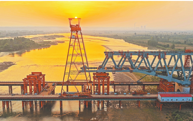
10月3日在河南省洛阳市孟津区拍摄的呼南高铁焦洛平段洛阳黄河公铁大桥施工现场。国庆假期期间，全国各地建设工地一片繁忙，工人们抢抓工期，加快建设。新华社发（白水平摄）
