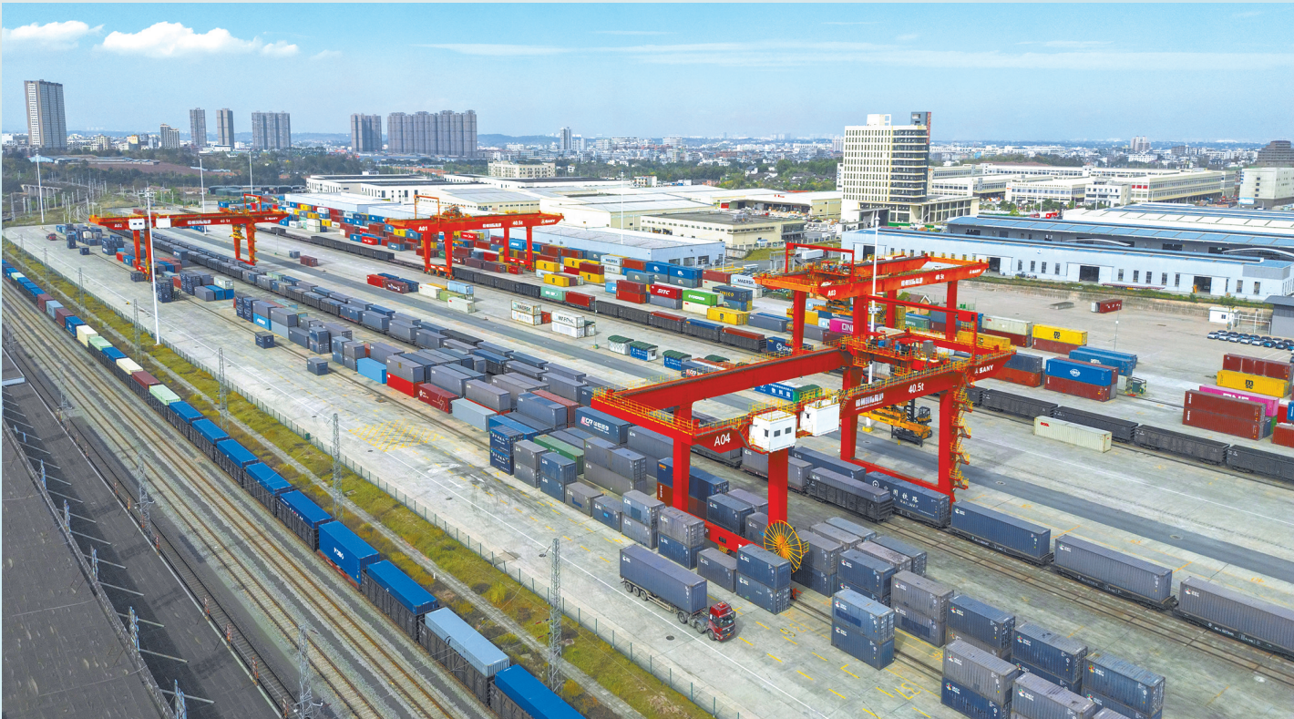
在赣州国际陆港货场,龙门吊正在吊运集装箱货柜,货车来来往往装卸作业,现场呈现一派繁忙景象。 本报全媒体首席记者 李 劼摄
