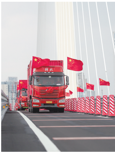
10月15日,货车行驶在中朝新鸭绿江大桥上。10月15日,中朝新鸭绿江大桥正式开通。 新华社记者 潘昱龙摄
